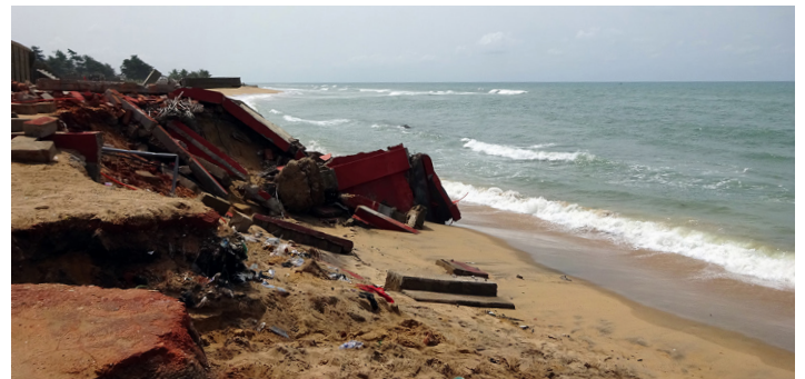
PHOTO 1 Habitations détruites par l'érosion à Baguida, Togo
