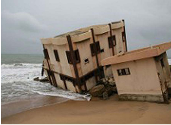
Cette photo du Palm Hotel est iconique: l'effondrement de l'hôtel béninois en 2002 a été attribué à l'érosion, en partie provoqué par l'extraction du sable.
